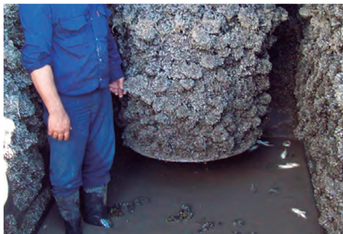
Incrustaciones en conductos de una planta potabilizadora. Paredes del túnel cubiertas por el mejillón dorado.
